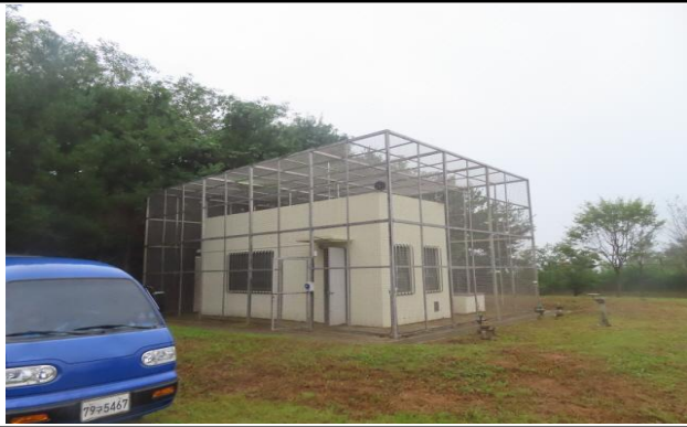
계단실 및 전기실 전경
