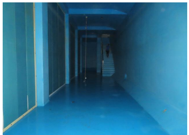
배수지 내부 전경
