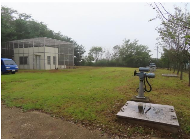
배수지 외부 전경
