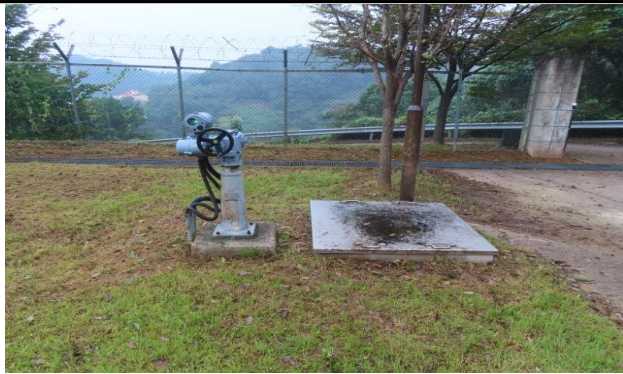
유입밸브실 1지 덮개 상태양호
