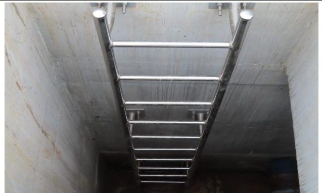
유입 밸브실 2지 수직형 사다리 상태양호
