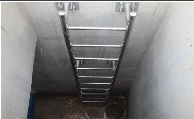
유입 밸브실 1지 수직형 사다리 상태양호
