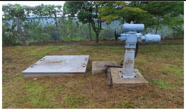
유입밸브실 2지 덮개 상태양호
